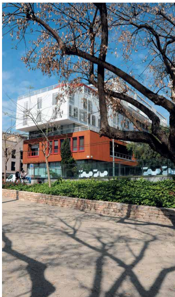
Edifici del Col·legi de Metges de Barcelona des dels Jardins del doctor Roig i Raventós.
